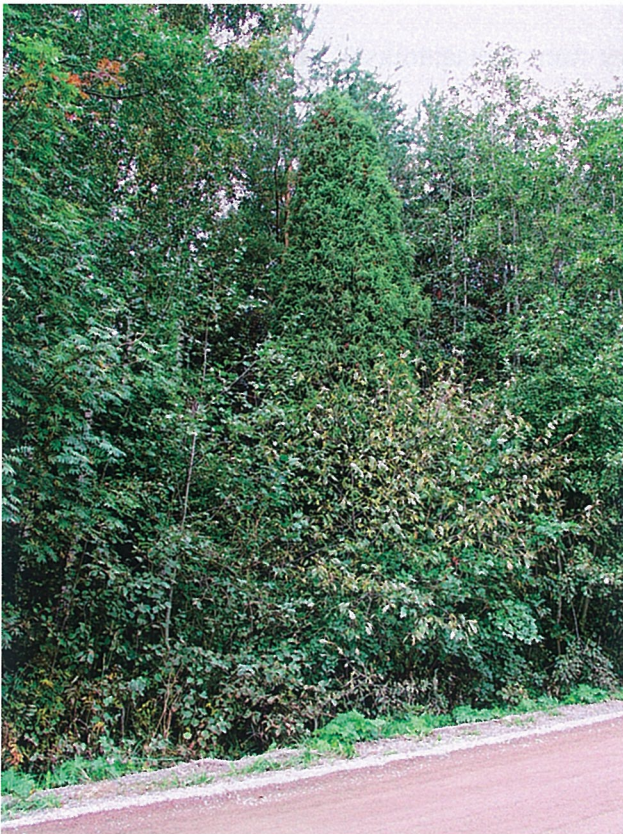
Kuva 2.7. Vanha pilarikataja Puustellintien varressa peittyä alaosastaan koiranheiden ja pajun taakse.
