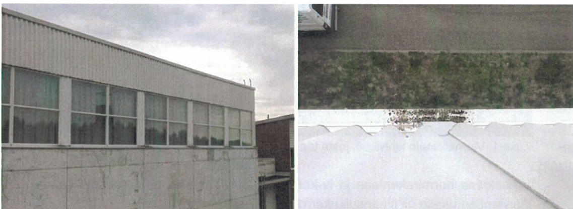
Kuvat 5 ja 6 liikuntasalin ikkunoiden pellitys
