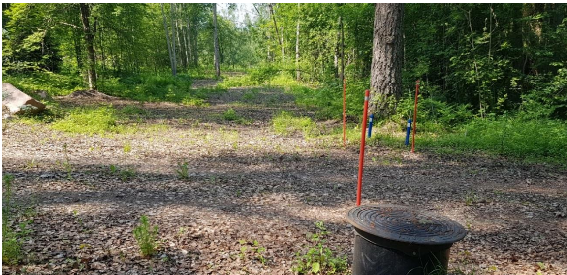
Kuva 4. Vanhan päärakennuksen ja saunan väliselle metsäalueelle oli kaivettu vesijohto. Länteen.
